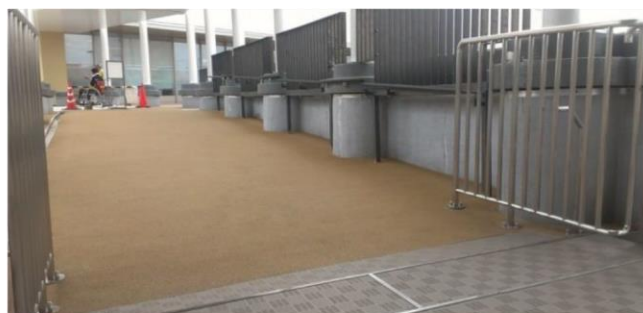
図 3. センター内のスロープ 1（勾配約 1/20）
