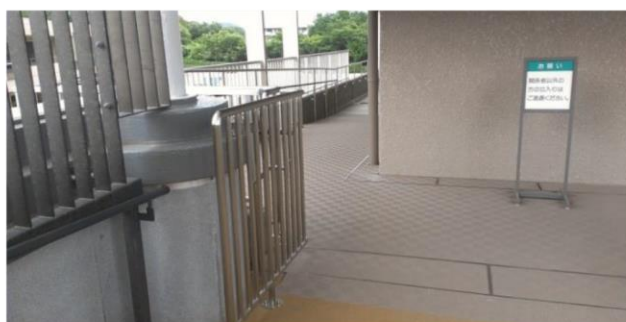
図 4. センター内のスロープ 2（勾配約 1/22）
