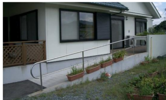
図 6. スロープ設置事例（勾配 1/12）
