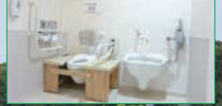
障害者用トイレ
