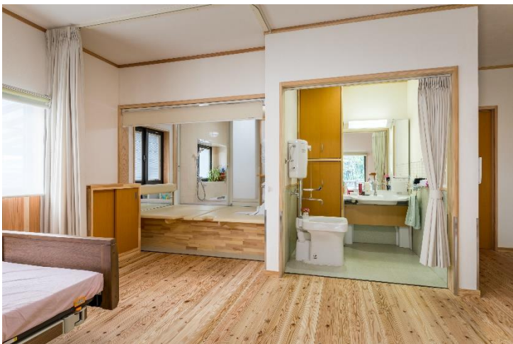
ご本人の寝室に、専用のトイレと洗面台を設置。右側スペースは、導尿用汚物流しと洗面化粧台。左側スペースは、排使用トイレを設置。トイレ奥は、浴室へつながる間取り。部屋との間仕切りにはカーテンを利用。
